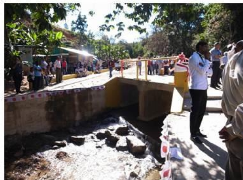
Vista del puente
